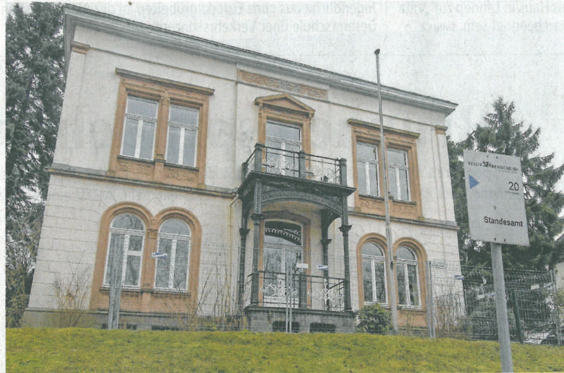
Das ehemalige Standesamt am Thüringsberg in Lennep ist verkauft und wird bis 2012 zur „ Villa Reisen “ umgebaut.
